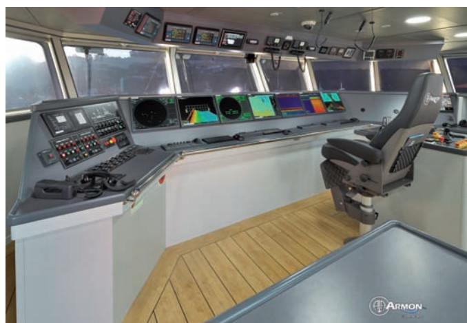
> Puente de navegación y comunicaciones.
